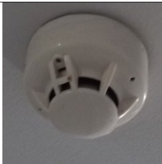
รูปที่ 2.4.6-6 อุปกรณ์ตรวจจับควันและความร้อน
