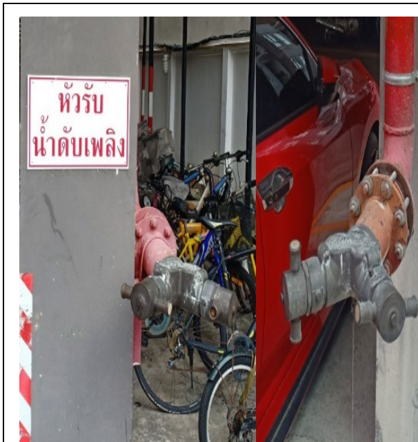
รูปที่ 2.4.6-1 หวัรับน้ำดับเพลิงภายนอกอาคาร
