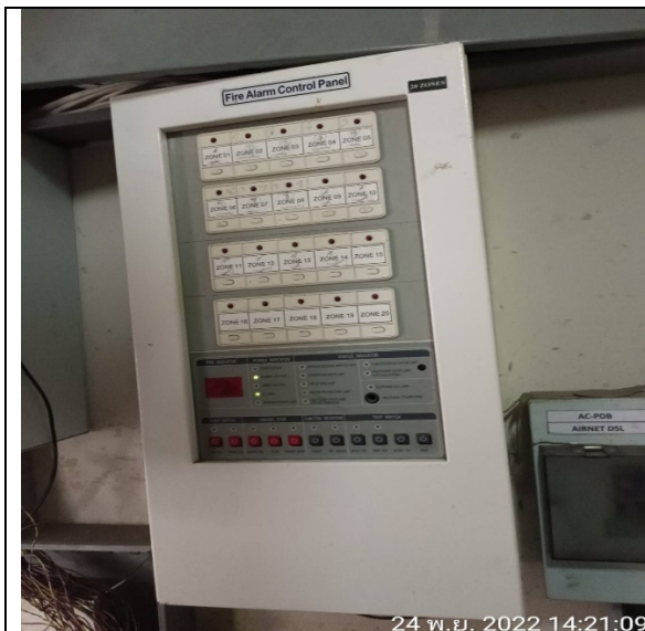
รูปที่ 2.4.6-5 แผงควบคุม (FCP)
