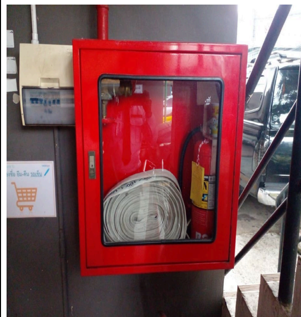
รูปที่ 2.4.6-2 ตู้เก็บสายน้ำดับเพลิงพร้อมอุปกรณ์
